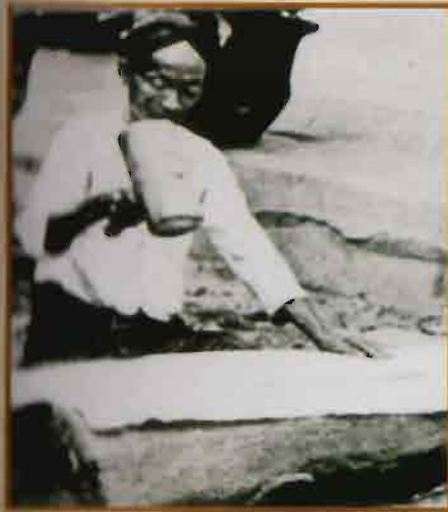
Proses Pembuatan Batik dengan Ngemplongi atau memukul-mukul kain (Khasanah ANRI)
